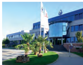
Construction du bloc administratif au PM Logistic Center Europe au Speyer (Allemagne).
