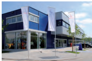
Construction d'un centre logistique et administratif en Suisse
